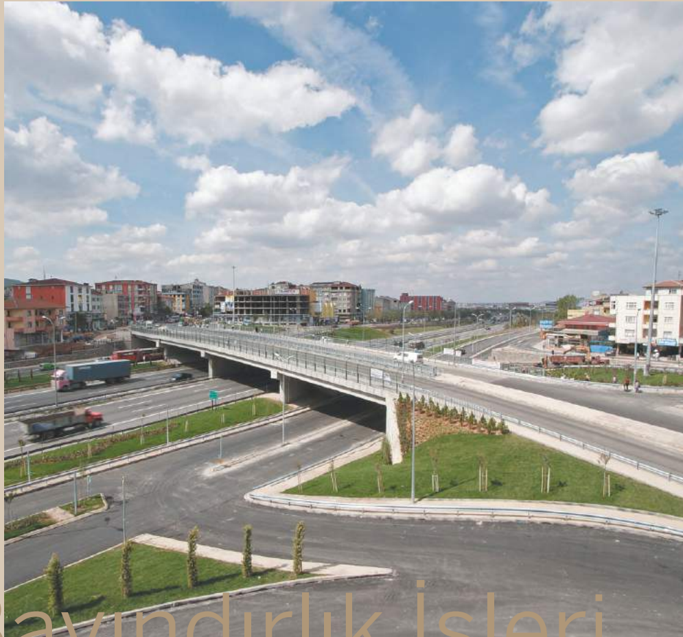
Sultanbeyli Köprü ve Yol Projesi, İstanbul
