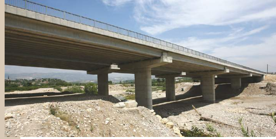
13.Cadde Köprü İnşaatı, Mersin
