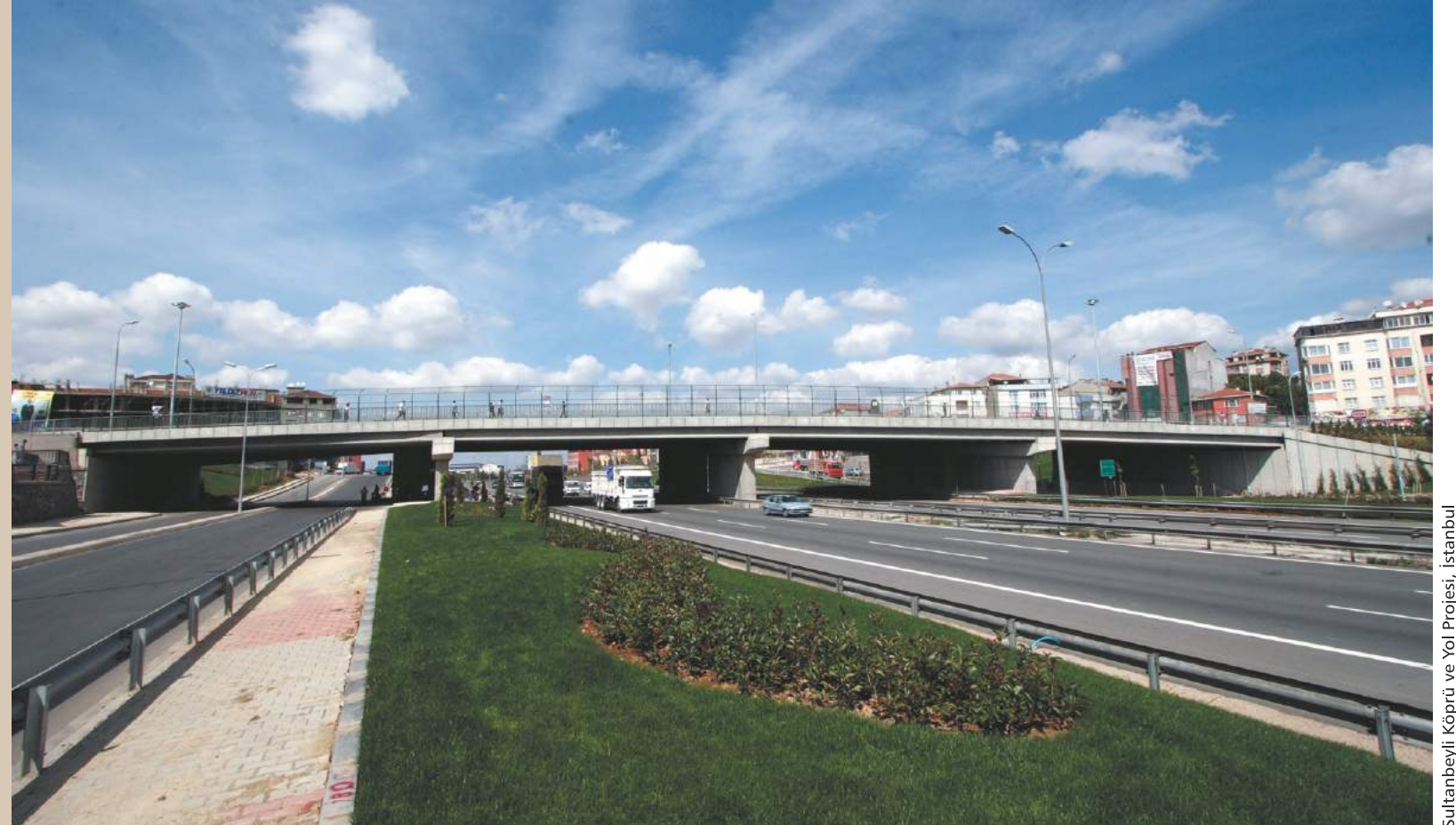
Sultanbeyli Köprü ve Yol Projesi, İstanbul
