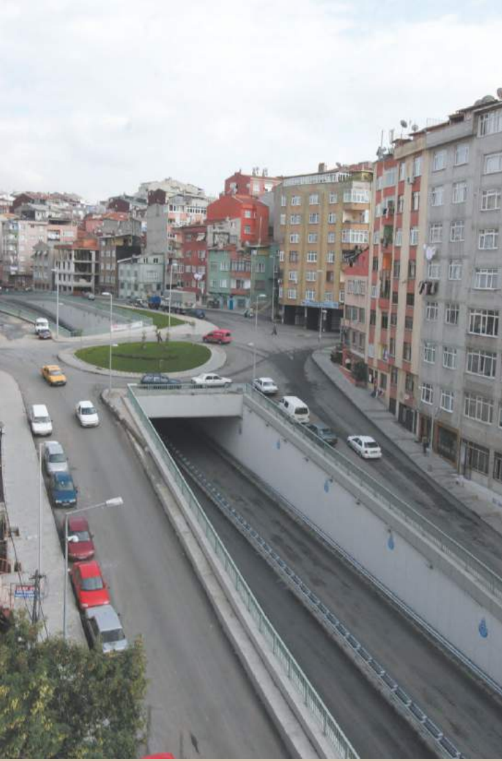
Kağıthane Alt Geçiti, Yol ve Altyapı Projesi, İstanbul
