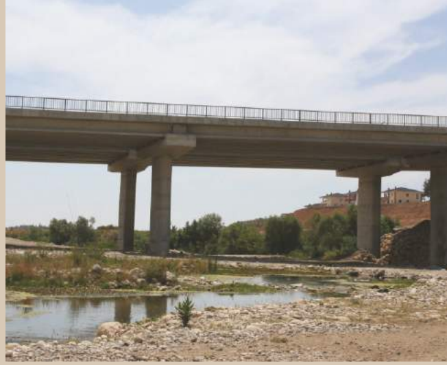
13. Cadde Köprü İnşaatı, Mersin
