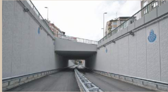
Kağıthane Alt Geçiti, Yol ve Altyapı Projesi, İstanbul
