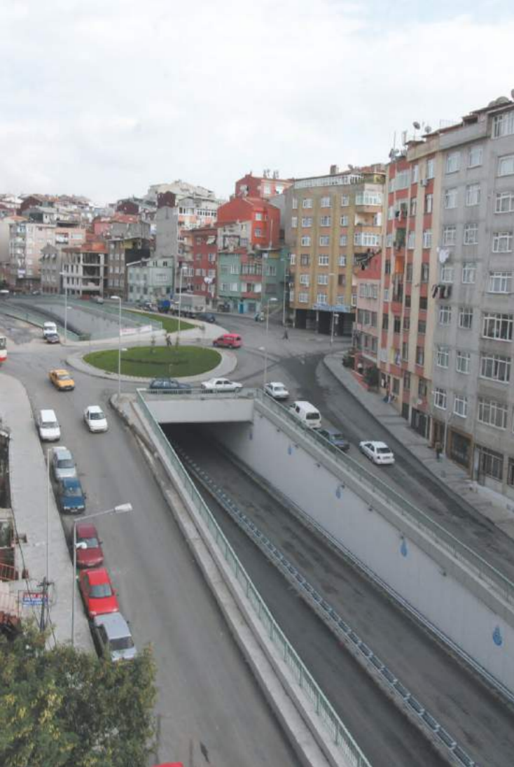
Passage inférieur, route et projet d'infrastructure Kağıthane, Istanbul
