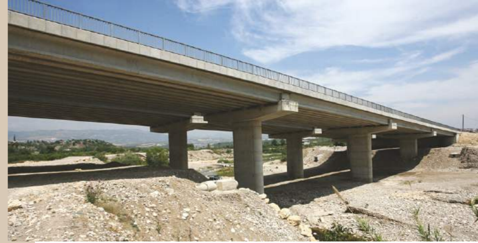
Construction de pont 13 th st., Mersin
