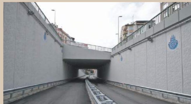
Passage inférieur, route et projet d'infrastructure Kağıthane, Istanbul
