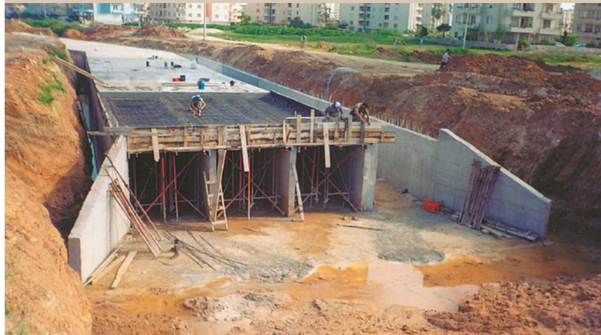
Conduite d'eau de ruissellement, Mersin
