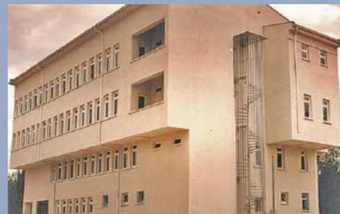
Centre de formation des apprentis
