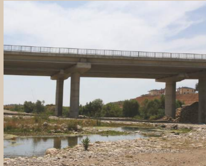
Construction de pont 13 th st., Mersin
